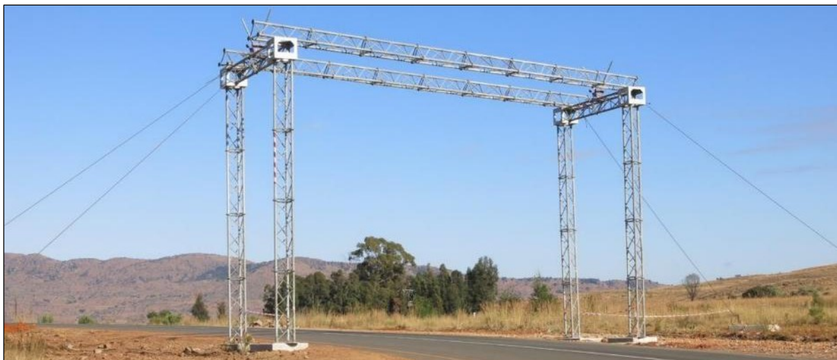
Obrázek č. 84: RopeCon – dočasná nosná konstrukce se zajištěním a ukotvením s technologií pro podepření tažného lana
