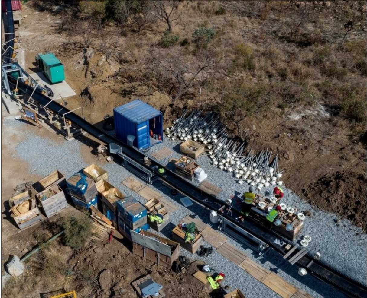
Obrázek č. 79: RopeCon – montážní linka náprav a kol (Doppelmayr, 2023)
