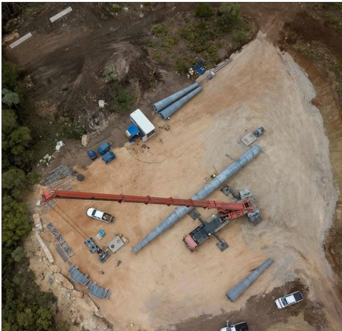
Obrázek č. 75: RopeCon – letecký snímek montáže 51 m vysoké věže typu A (Doppelmayr, 2023)
