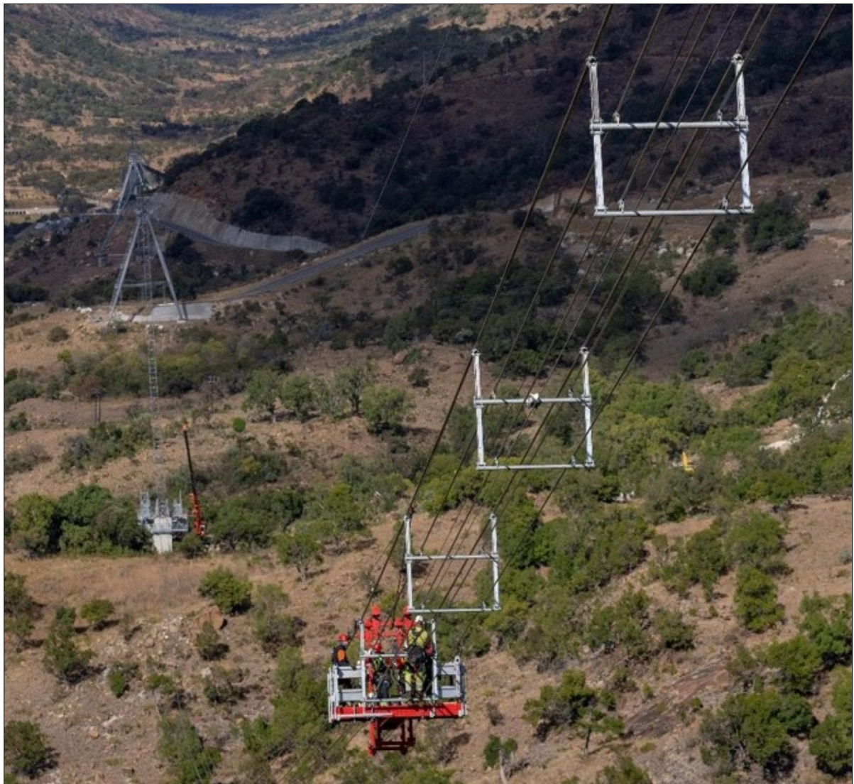
Obrázek č. 78: RopeCon – instalace rámu nosných lan (Doppelmayr, 2023)
