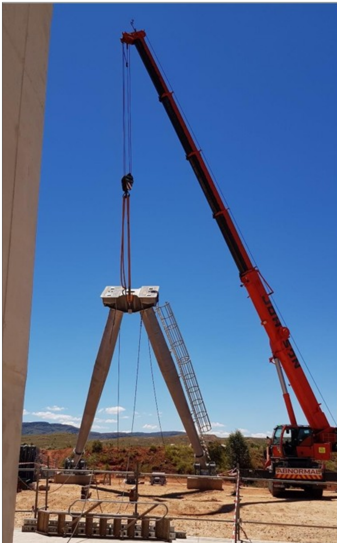
Obrázek č. 76: RopeCon – zvedání menší věže montované v horizontální poloze (Doppelmayr, 2023)
