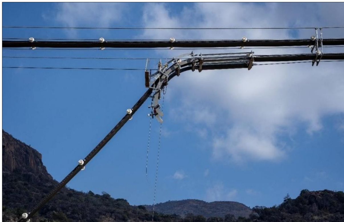
Obrázek č. 80: RopeCon – nástroj pro vytahování pásů (Doppelmayr, 2023)
