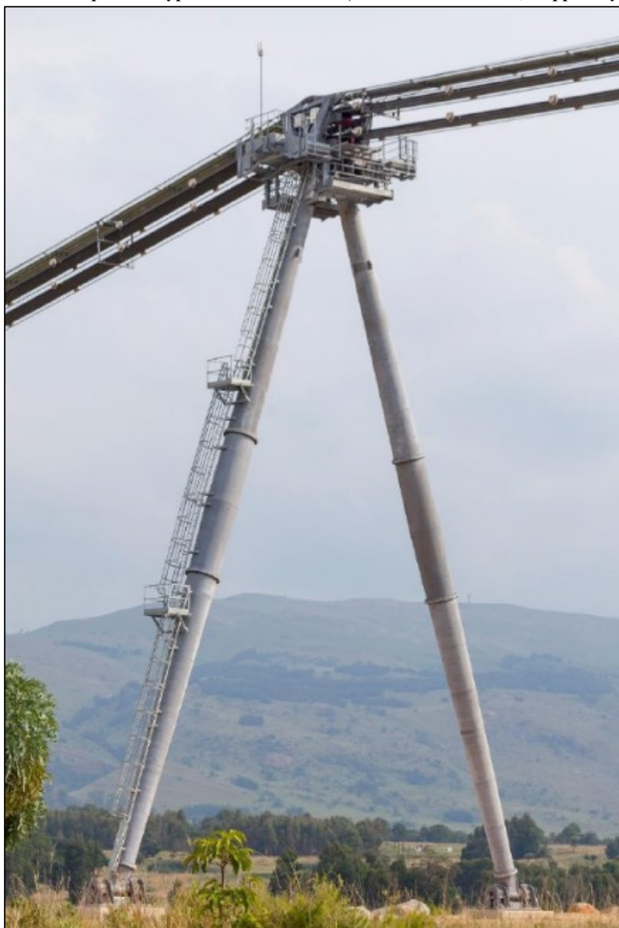
Obrázek č. 64: RopeCon – typická věž s A-rámem (ilustrativní charakter; Doppelmayr, 2023)
